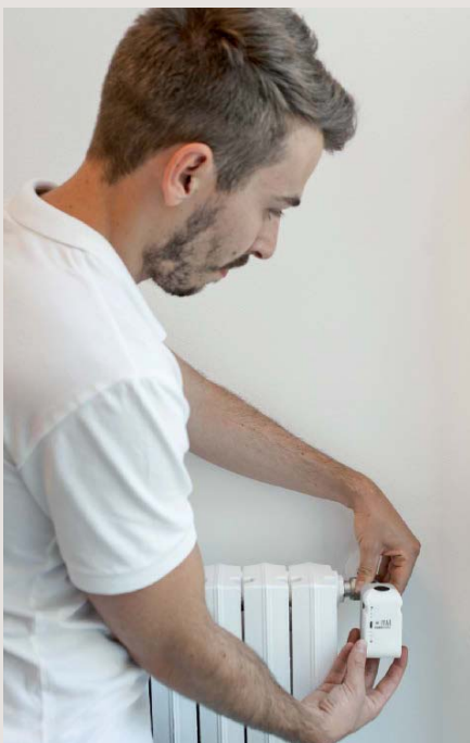
MONTARE l'attuatore sulla valvola termostattabile del radiatore
