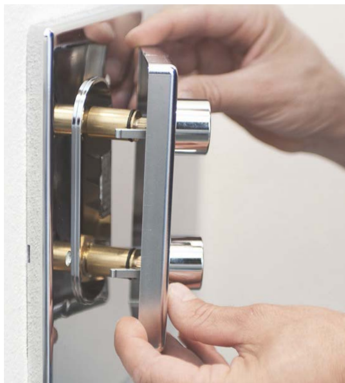
7. AVVITARE senza stringere a fondo, per evitare di piegare il coperchio.
