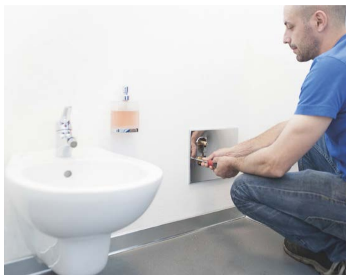
7. AVVITARE senza stringere a fondo, per evitare di piegare il coperchio.
