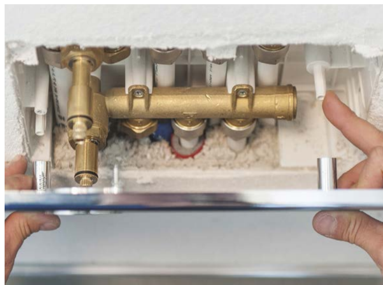
6. APPLICARE il coperchio a vista in modo che i perni della cassetta combacino con i fori del coperchio stesso.
